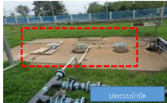
รูปที่ 5 ระบบบำบัดน้ำเสียสำเร็จรูป
